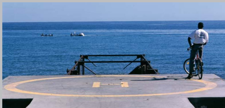
Restes du pont métallique sur le front de mer de St Paul. Collection privée
