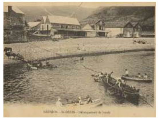
Chaloupe de transbordement de Saint Denis
